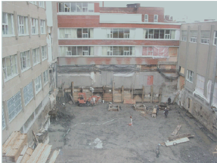
Fig. 7. L'excavation au milieu des édifices existants. Source collège international Marie de France, 2007, bulletin.
