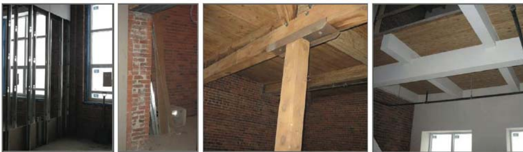
Fig. 9. Photos pendant les travaux (2007)
