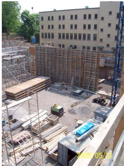
Fig. 6. Construction du gymnase souterrain (source : ville de Westmount, 2006)
