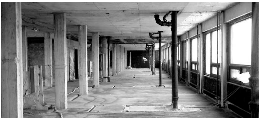
Fig.6. Structure dénudée (Comité Logement Rosemont, 2008, p.16)
