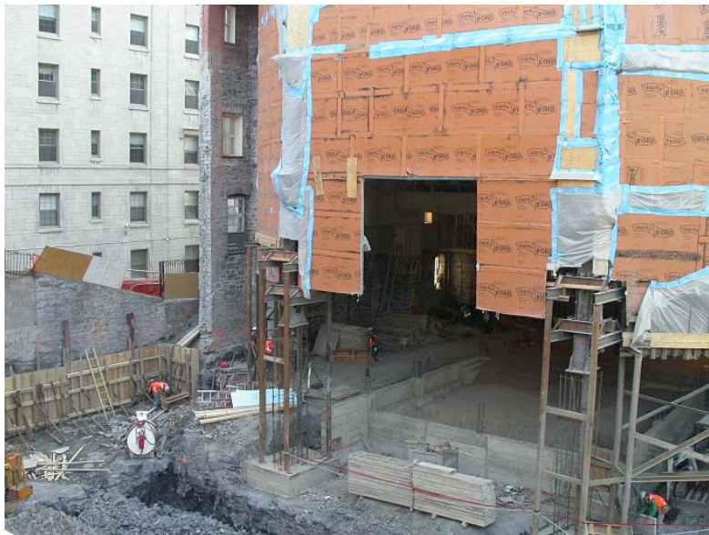
Fig. 8. Démantèlement de la partie ouest pour excavation (Source : PR-AA, 2011)
