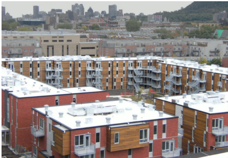
Fig. 2. Photographie de l'ensemble du projet complété (Source : MTLURB, 2012)
