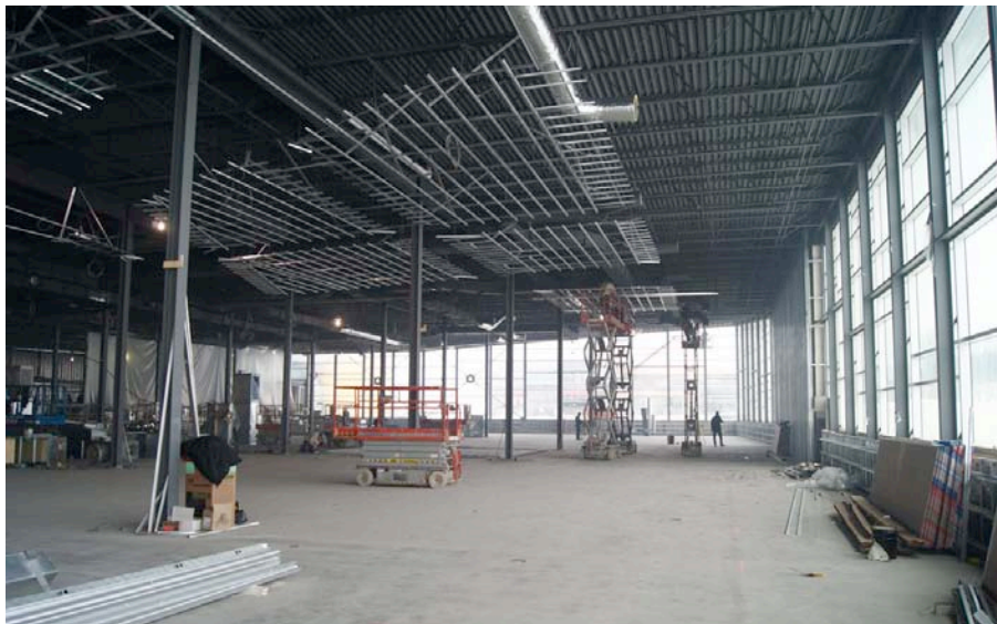
Fig. 6. Photo du chantier, vue du plafond dans le magasin
